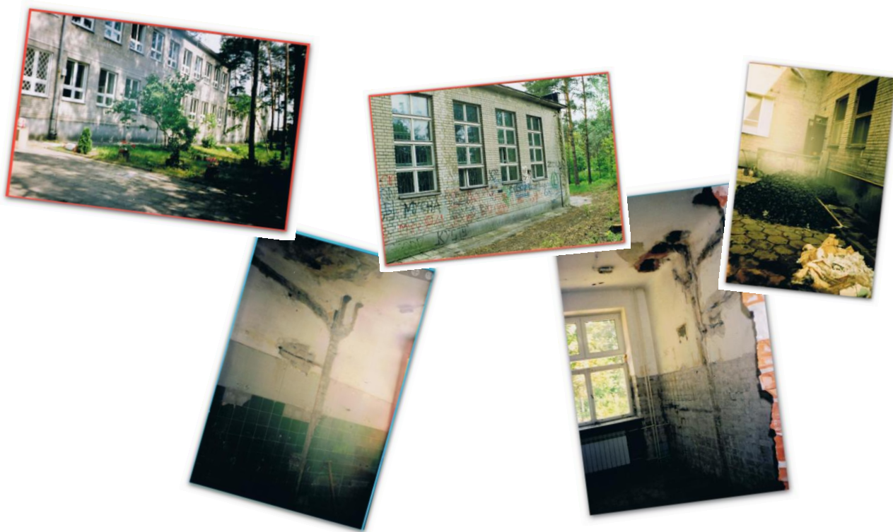
Ośrodek przed i podczas remontu
